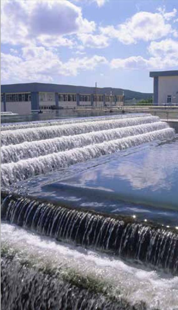
Ömerli İçme Suyu Arıtma Tesisi
