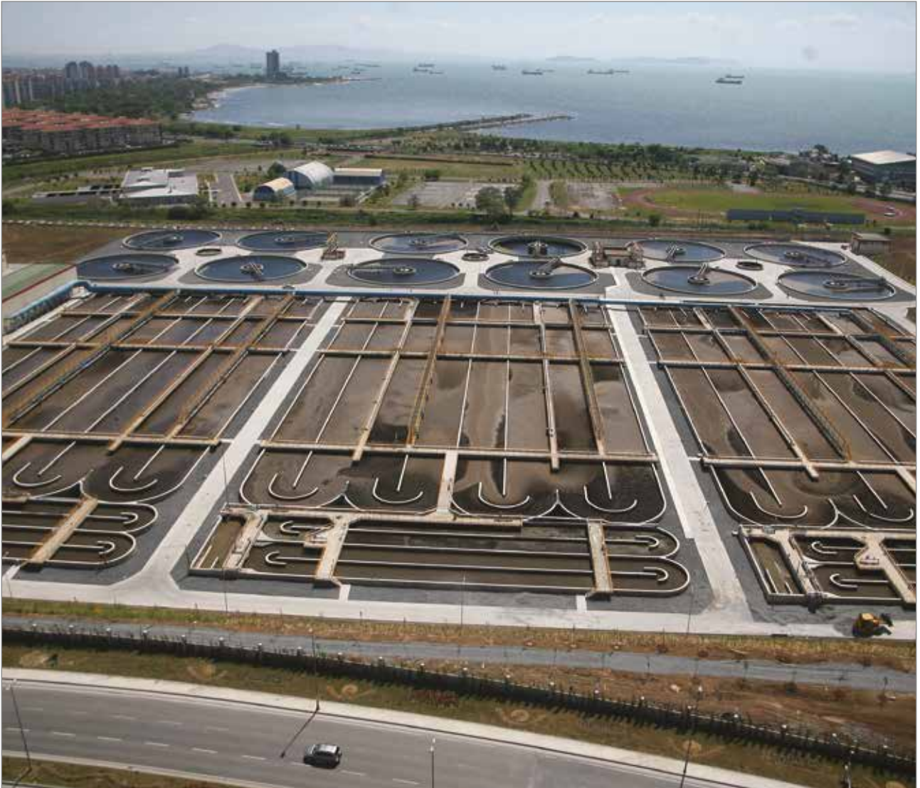
Ataköy İleri Biyolojik Atık Su Arıtma Tesisi
