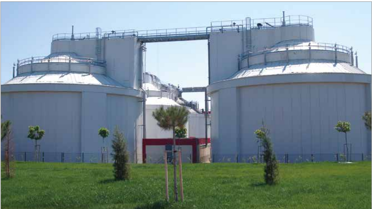
Ataköy İleri Biyolojik Atık Su Arıtma Tesisi - Biyogaz Üniteleri
