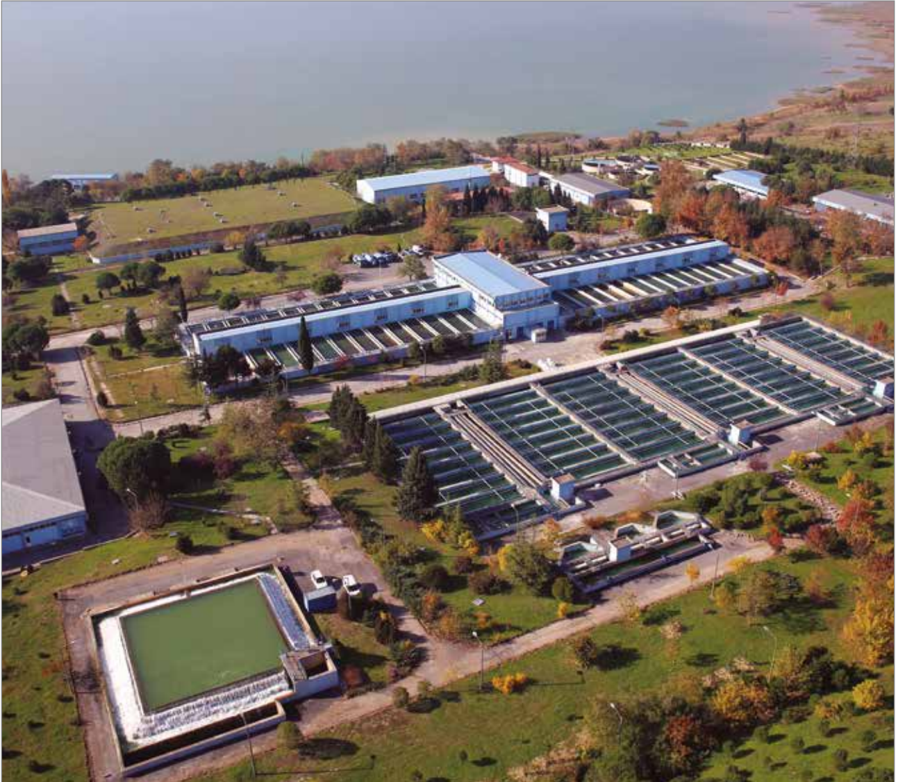
Büyükcemece İçme Suyu Arıtma Tesisi
