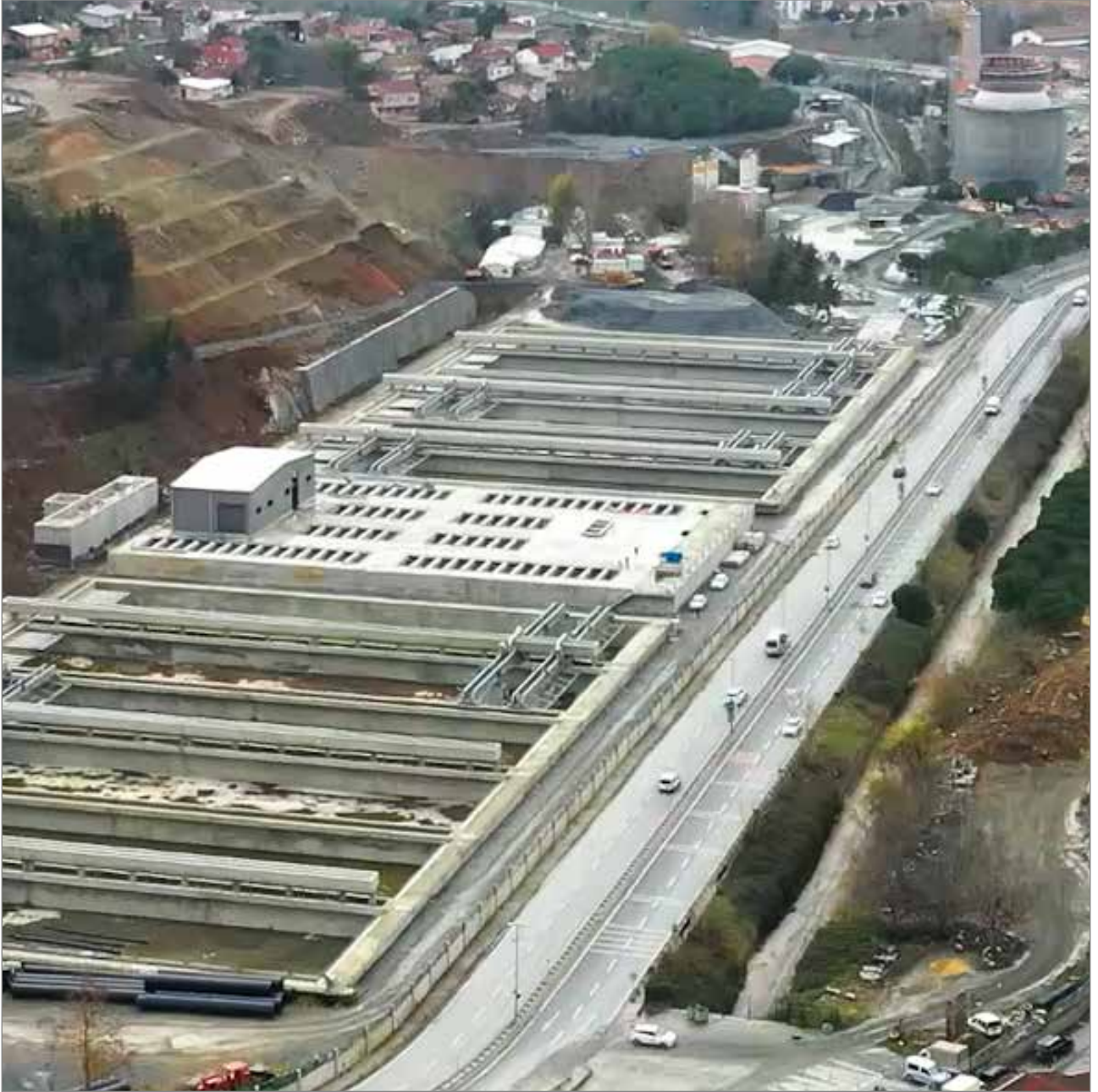
Baltalımanlı Biyolojik Atık Su Arıtma Tesisi İnşaatı
