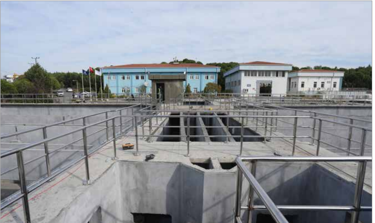
Taşoluk Çıme Suyu Arıtma Tesisi İnşaatı
