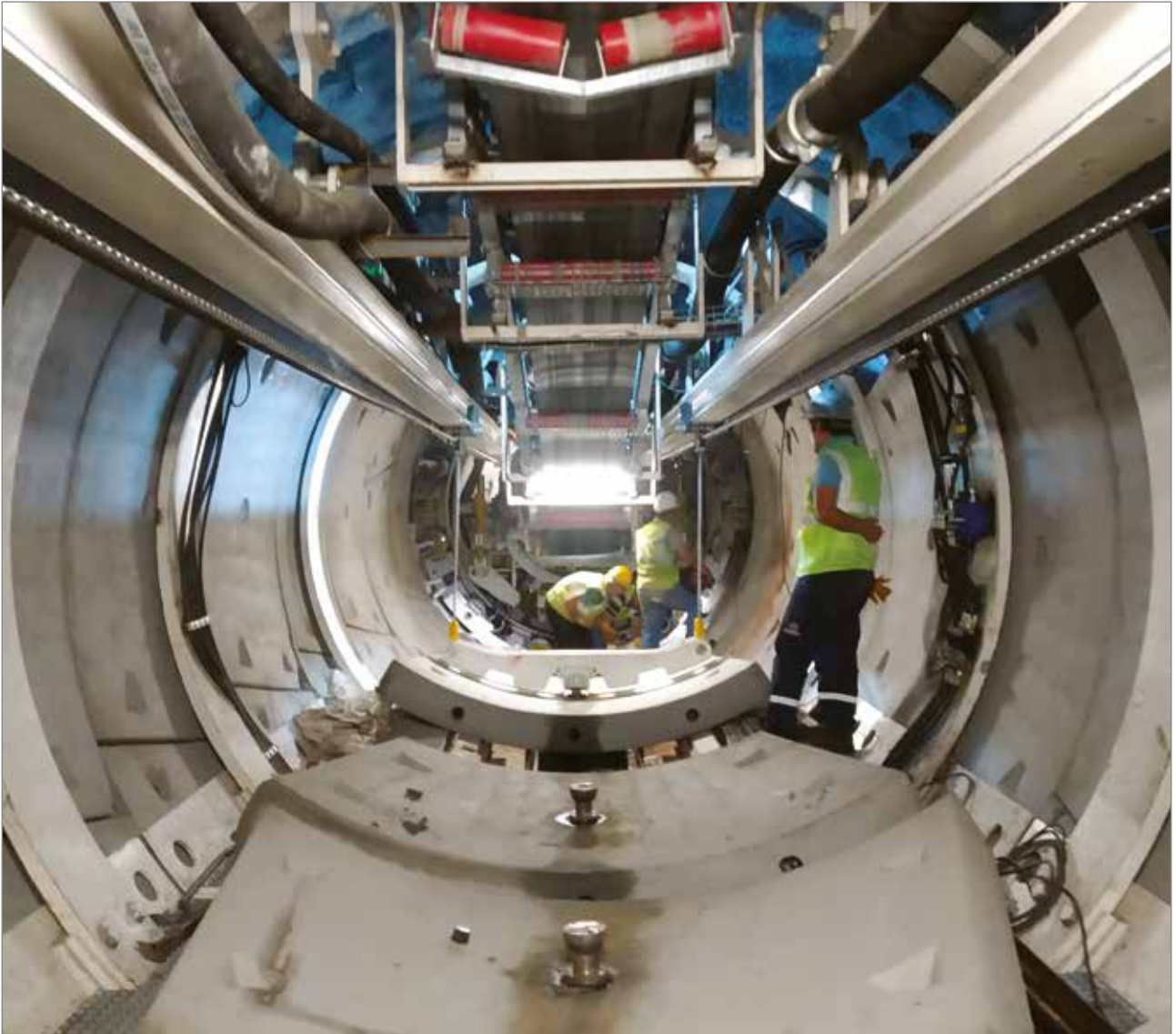
Ayvalıdere Atık Su Tünel Çalışması
