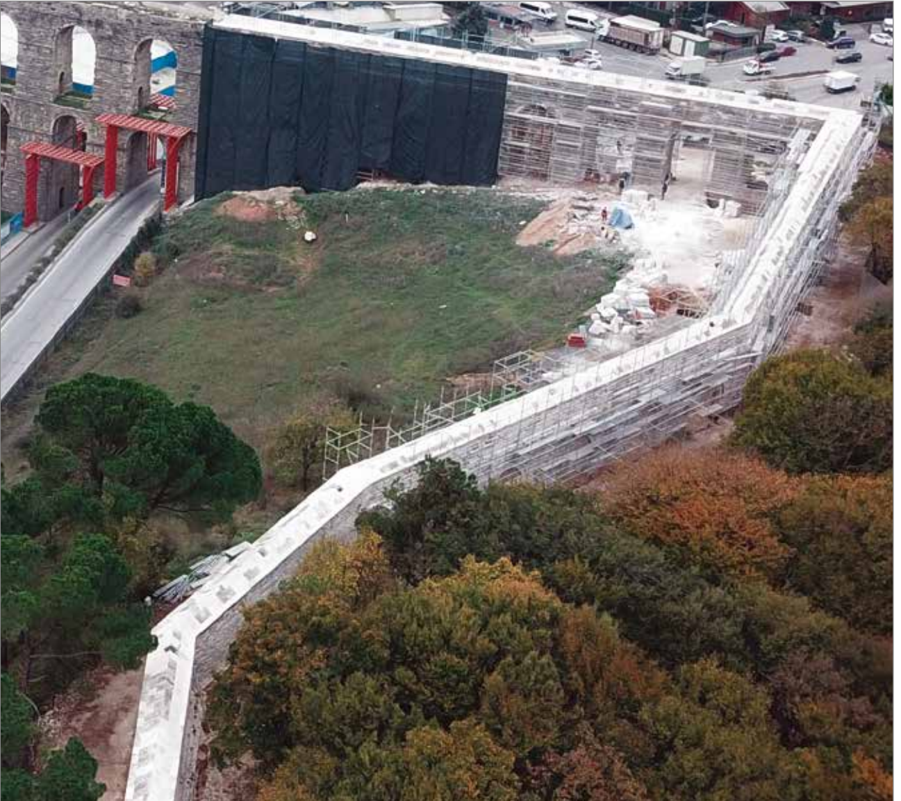
Eğri Kemer Restorasyonu
