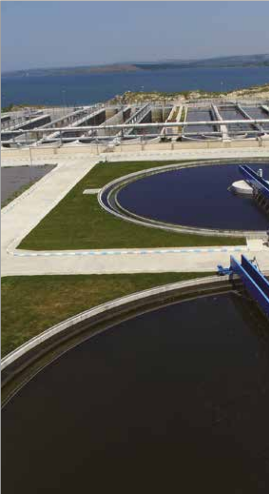
Büyükçekmece İleri Biyolojik Atık Su Arıtma Tesisi
