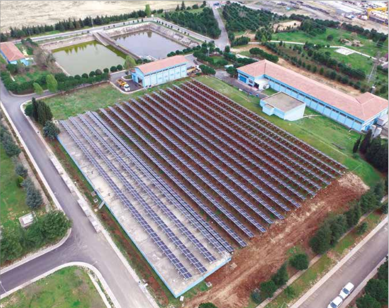
İkitelli Çıme Suyu Arıtma Tesisi - Güneş Enerjisi Santrali
