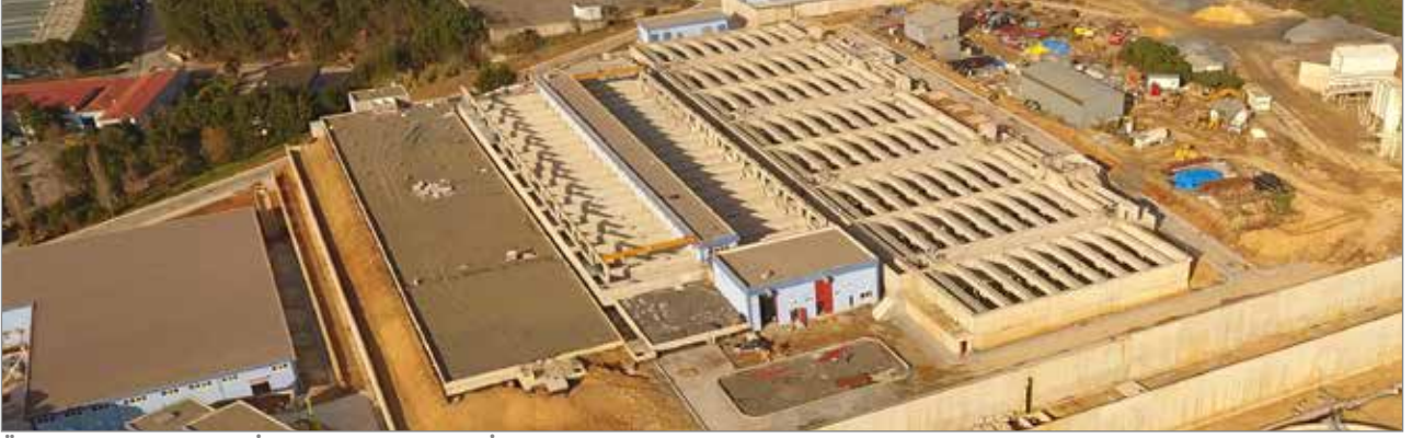
Ömerli-Emirli (2. Kademe) İçme Suyu Arıtma Tesisi İnşaatı
