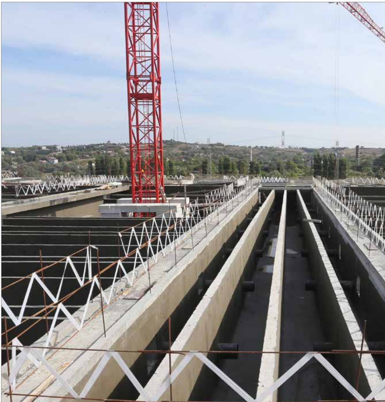
Terkos İçme Suyu Arıtma Tesisi İnşaatı
