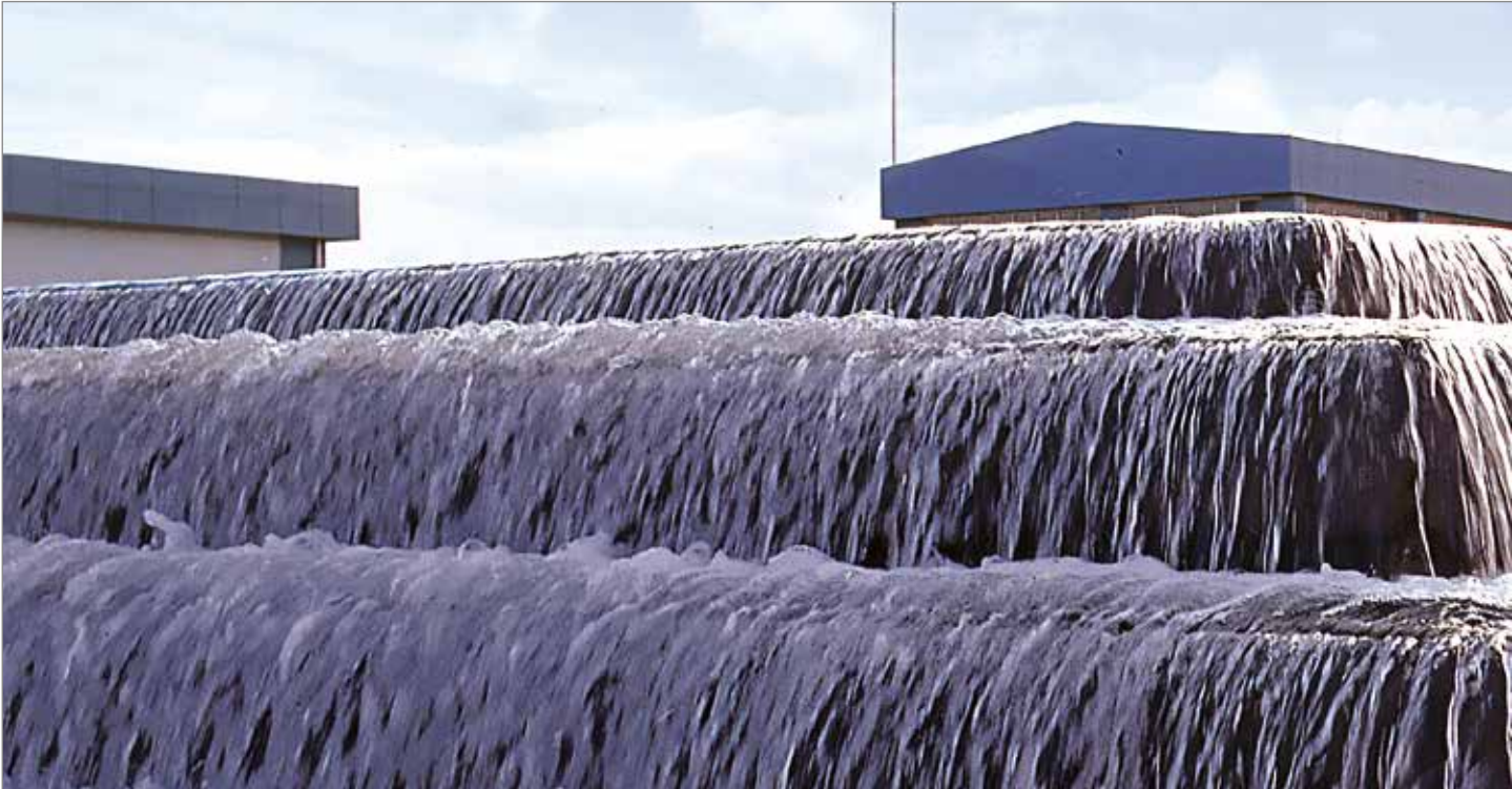
Kağıthane İçme Suyu Arıtma Tesisi Havalandırma Havuzu
