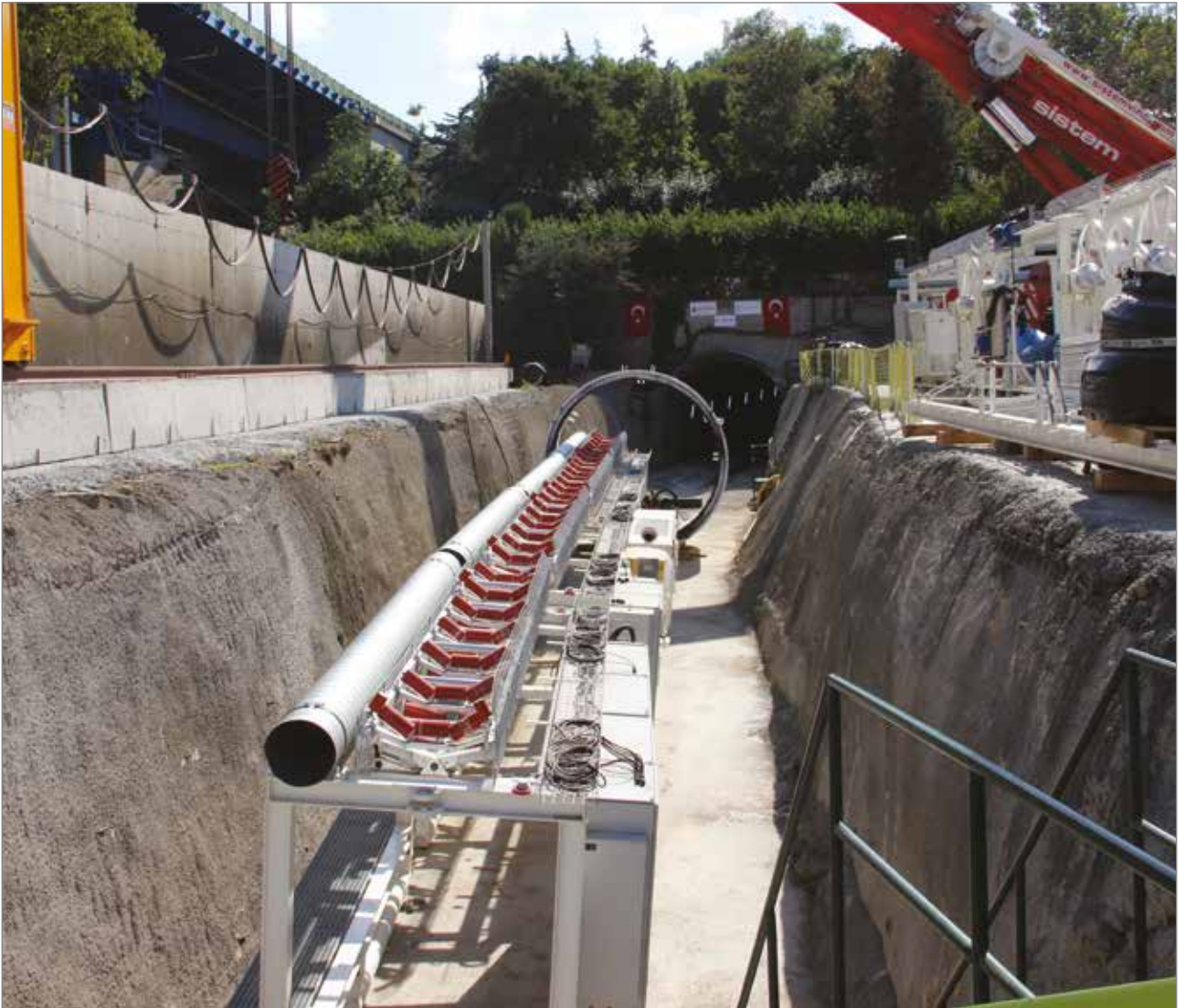
Ayvalıdere Atık Su Tüneli İnşaatı
