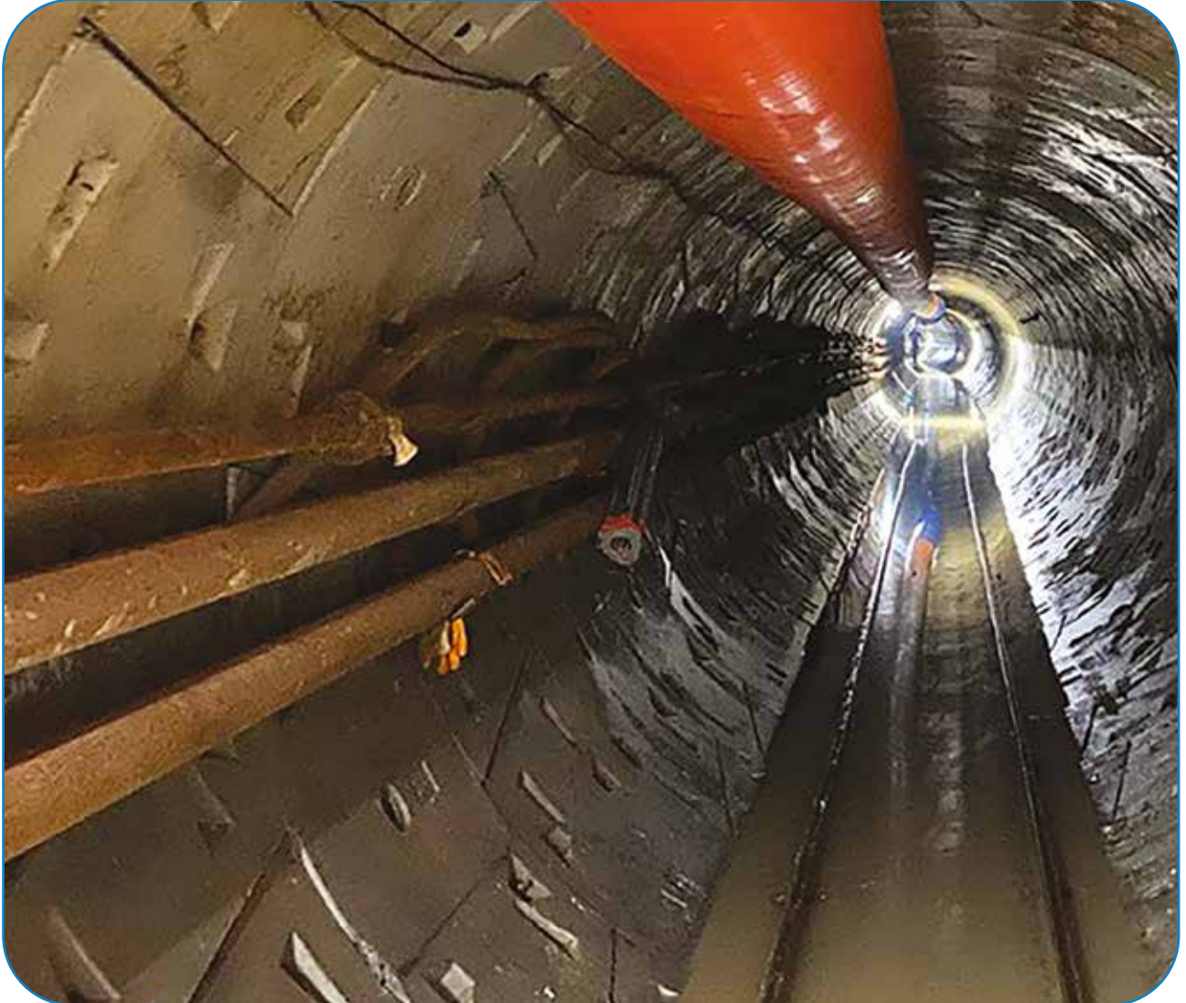
Atık Su Tünel Çalışması
