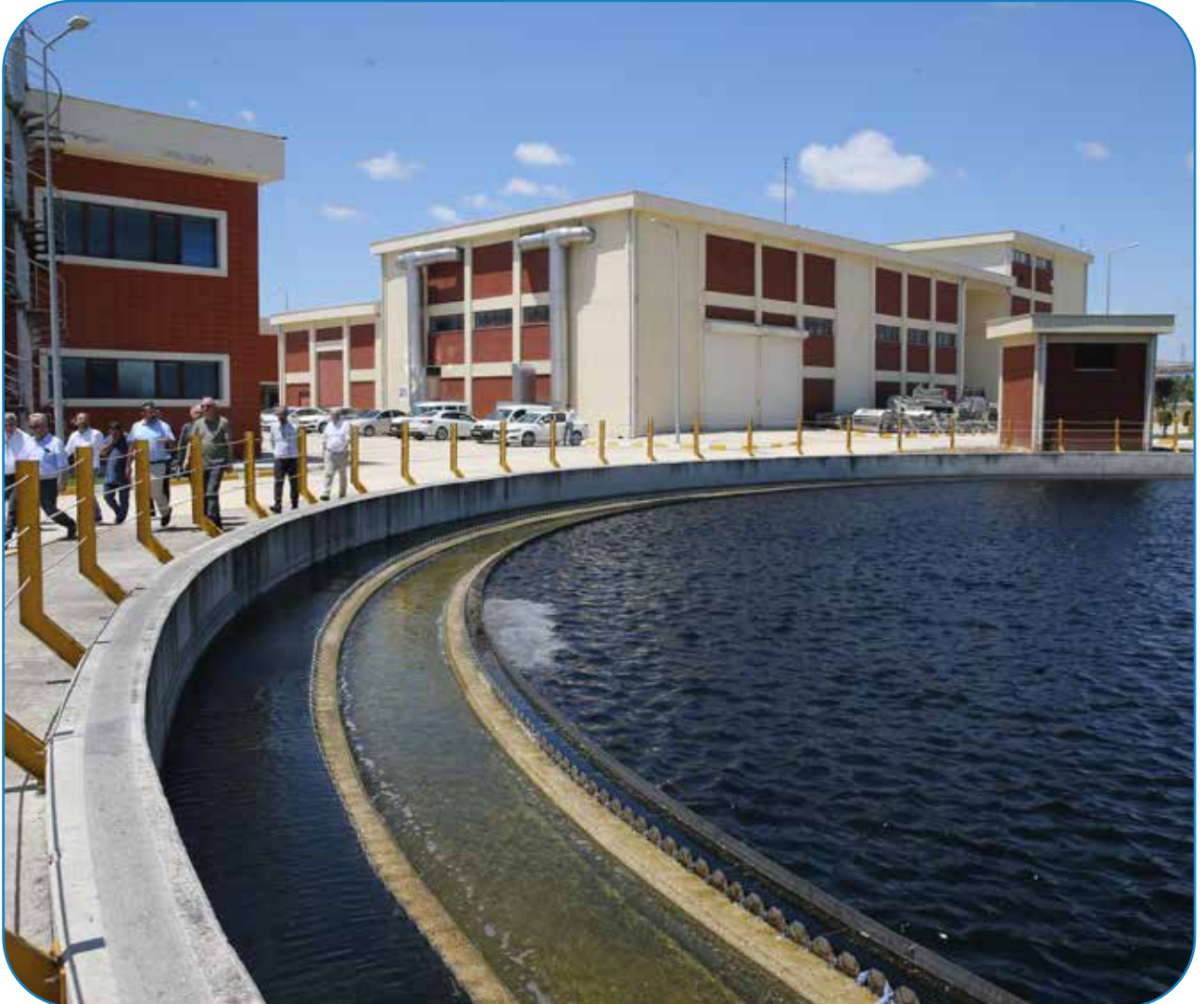
Çanta İleri Biyolojik Atık Su Arıtma Tesisi
