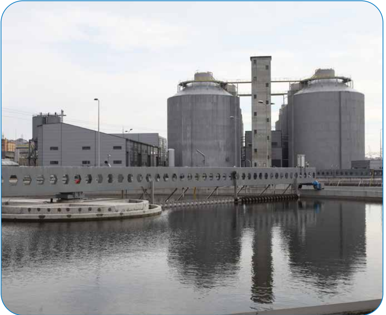
Ambarlı İleri Biyolojik Atık Su Arıtma Tesisi
