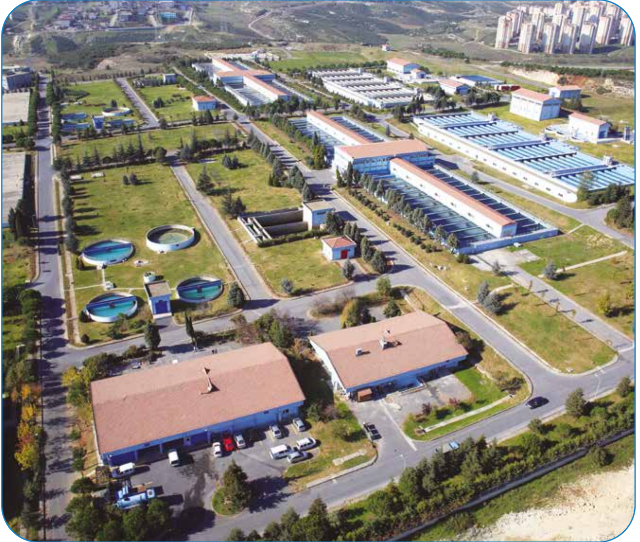
İkitelli Çıme Suyu Arıtma Tesisi
