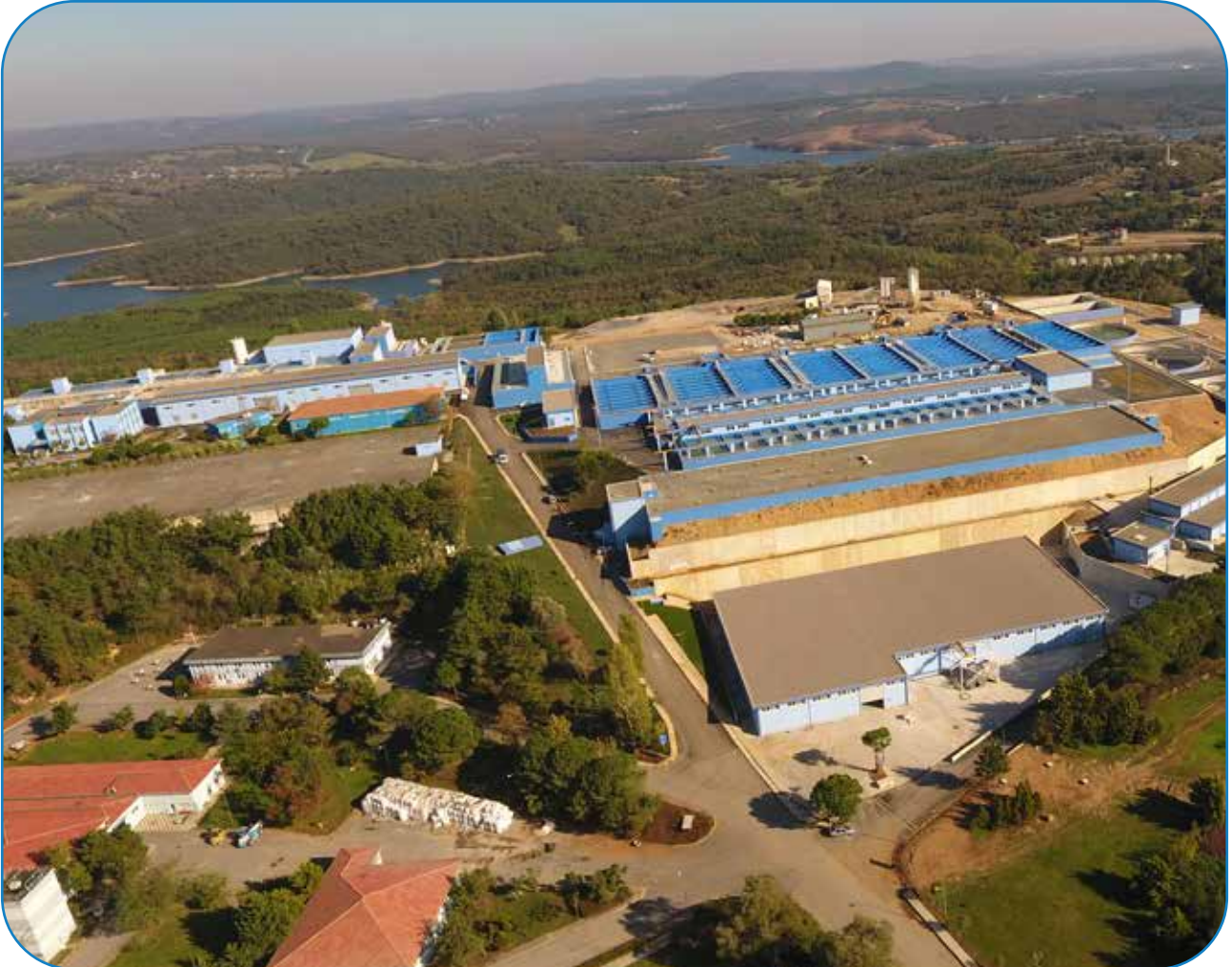
Ömerli-Emirli II. Kademe İçme Suyu Arıtma Tesisi
