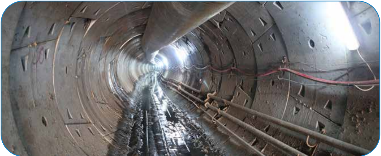
Unkapanı Yağmur Suyu Tüneli İnşa Çalışmaları
