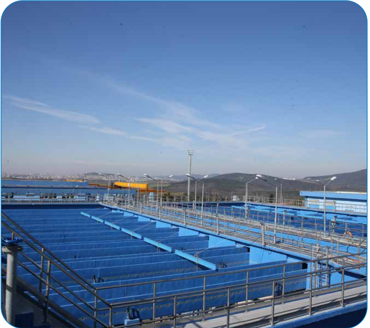
Ömerli İçme Suyu Arıtma Tesisi
