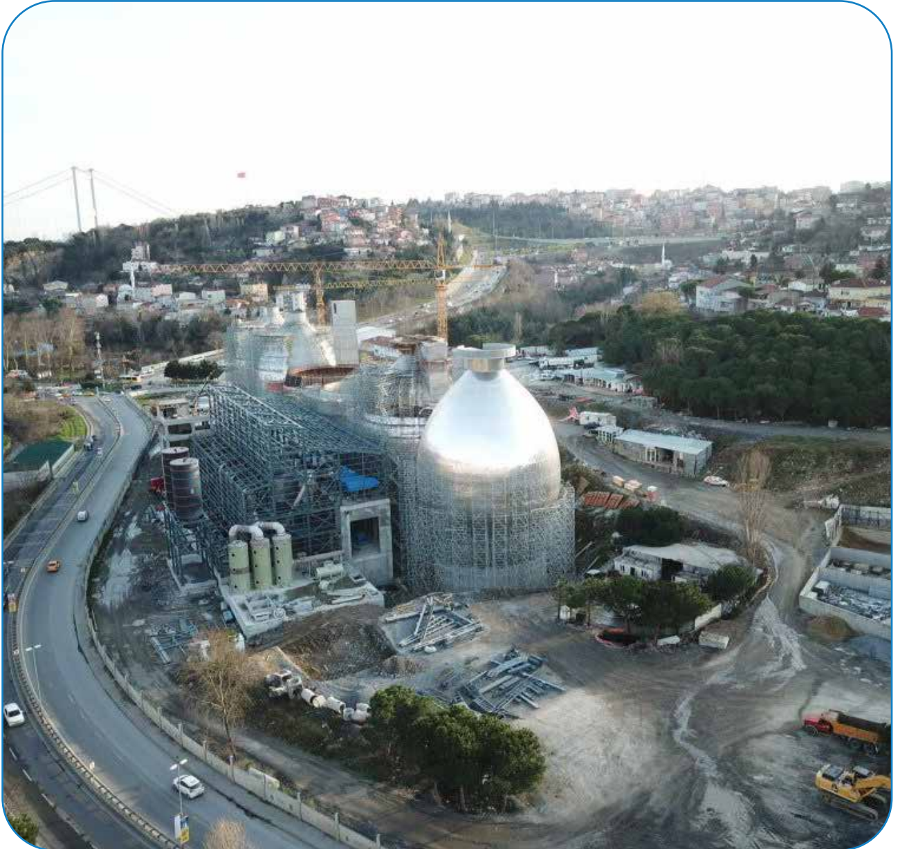
Baltalimanı Biyolojik Atık Su Arıtma Tesisi İnşaatı
