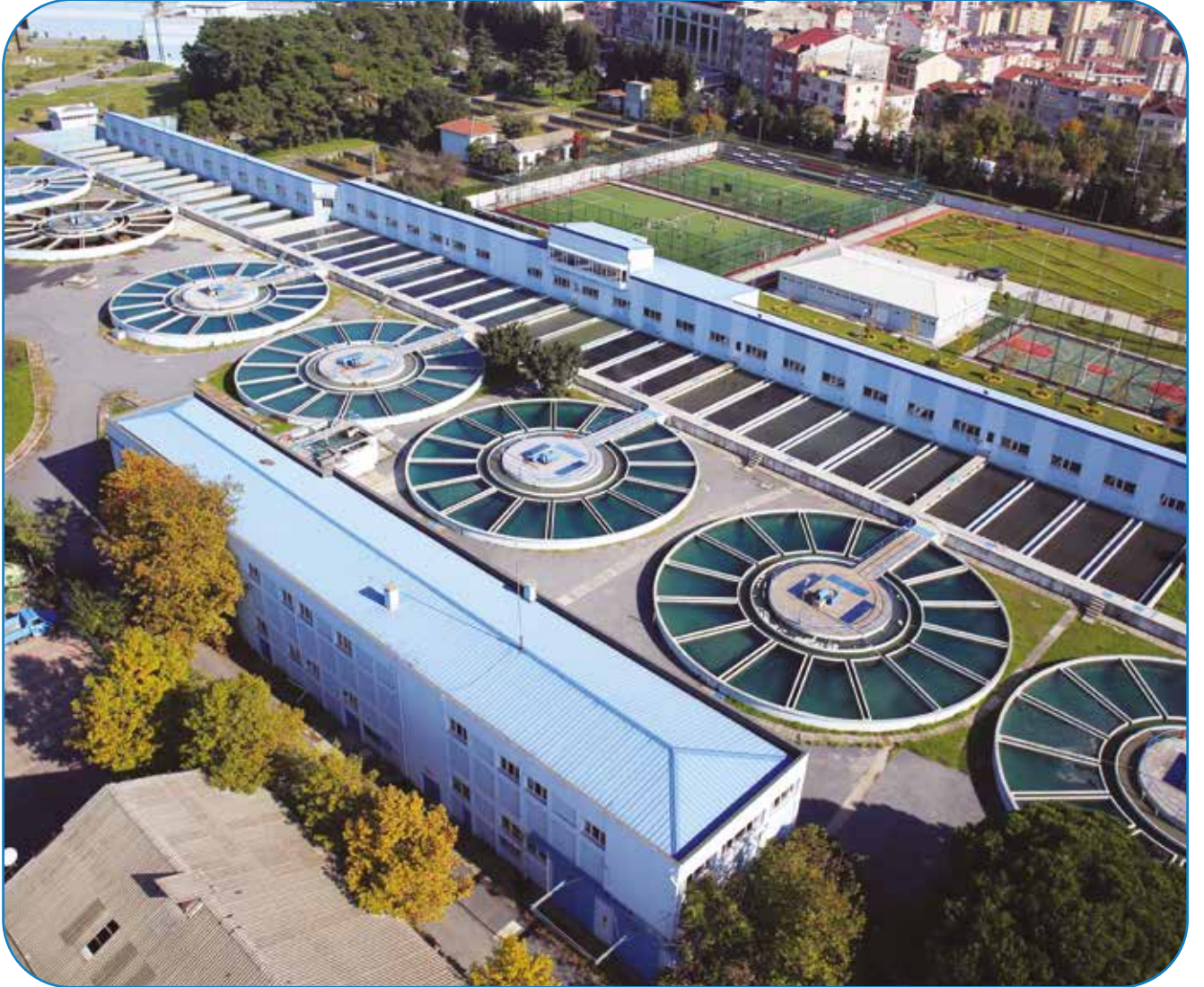
Kağıthane İçme Suyu Arıtma Tesisi
