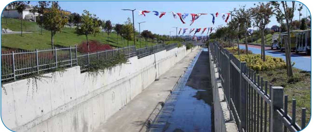
Kavaklıdere Dere Islah Çalışmaları
