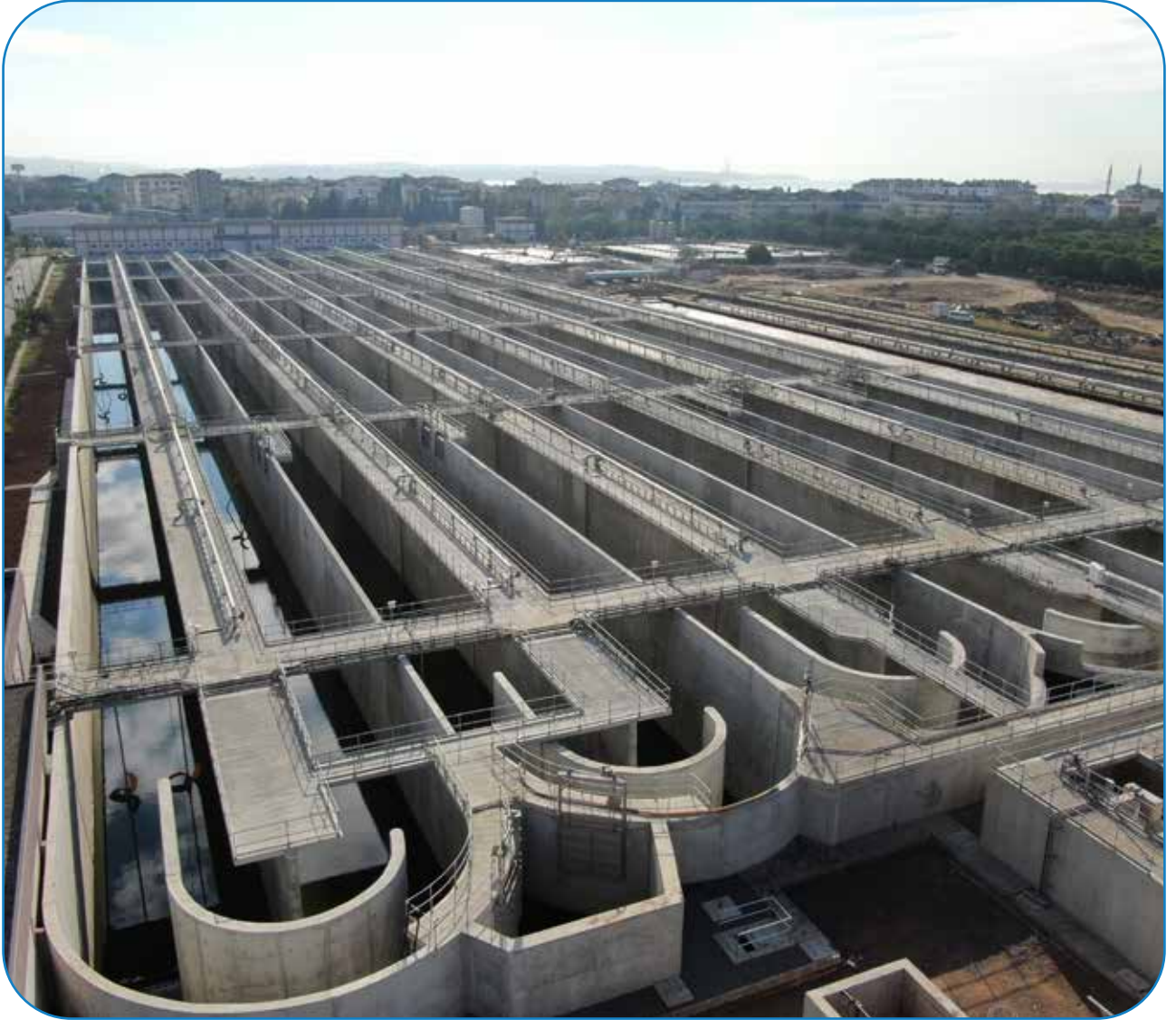
Tuzla İleri Biyolojik Atık Su Arıtma Tesisi III. Kademe İnşaatı
