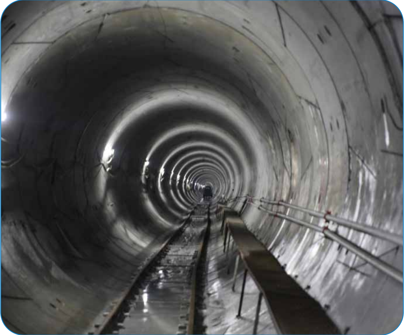
Kağıthane-Bahçelievler ve Bahçelievler-Sefaköy İçme Suyu Tünel İnşaatı
