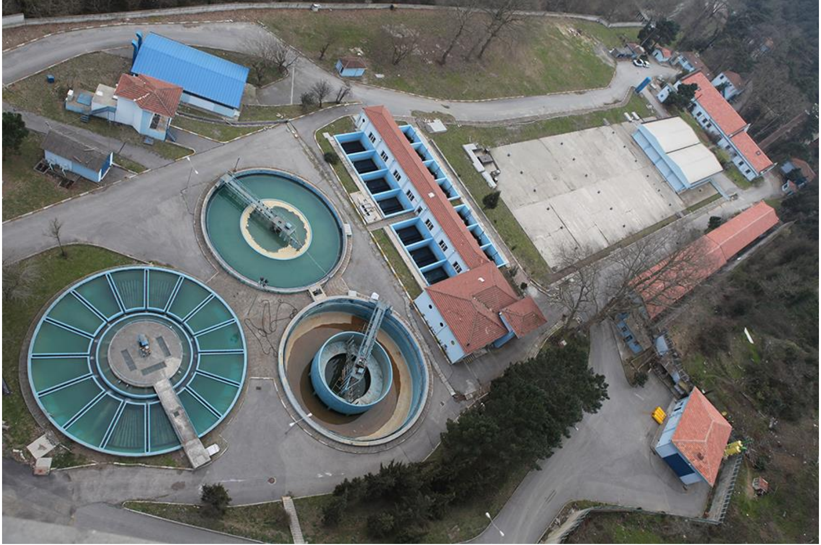
İSKİ Elmalı İçme Suyu Arıtma Tesisi
