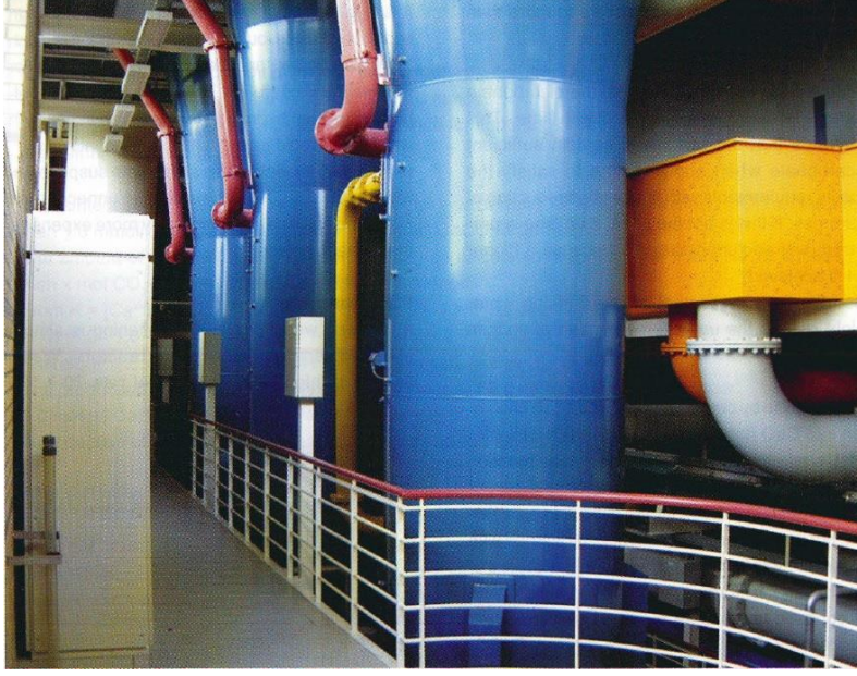
Şekil 7.8 Drenthe – Hollanda’da bulunan bir pelet reaktör.
