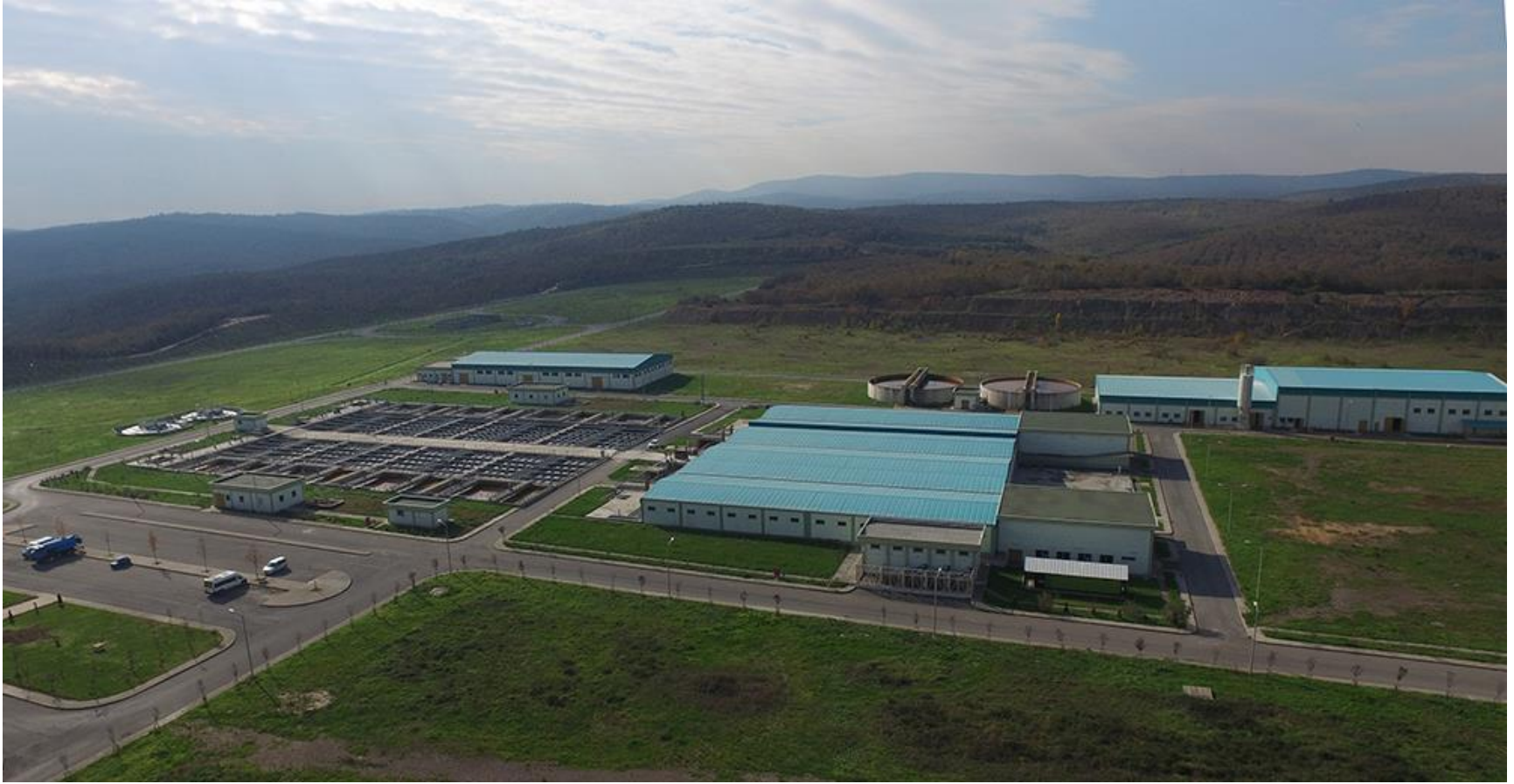
İSKİ Cumhuriyet İçme Suyu Arıtma Tesisi
