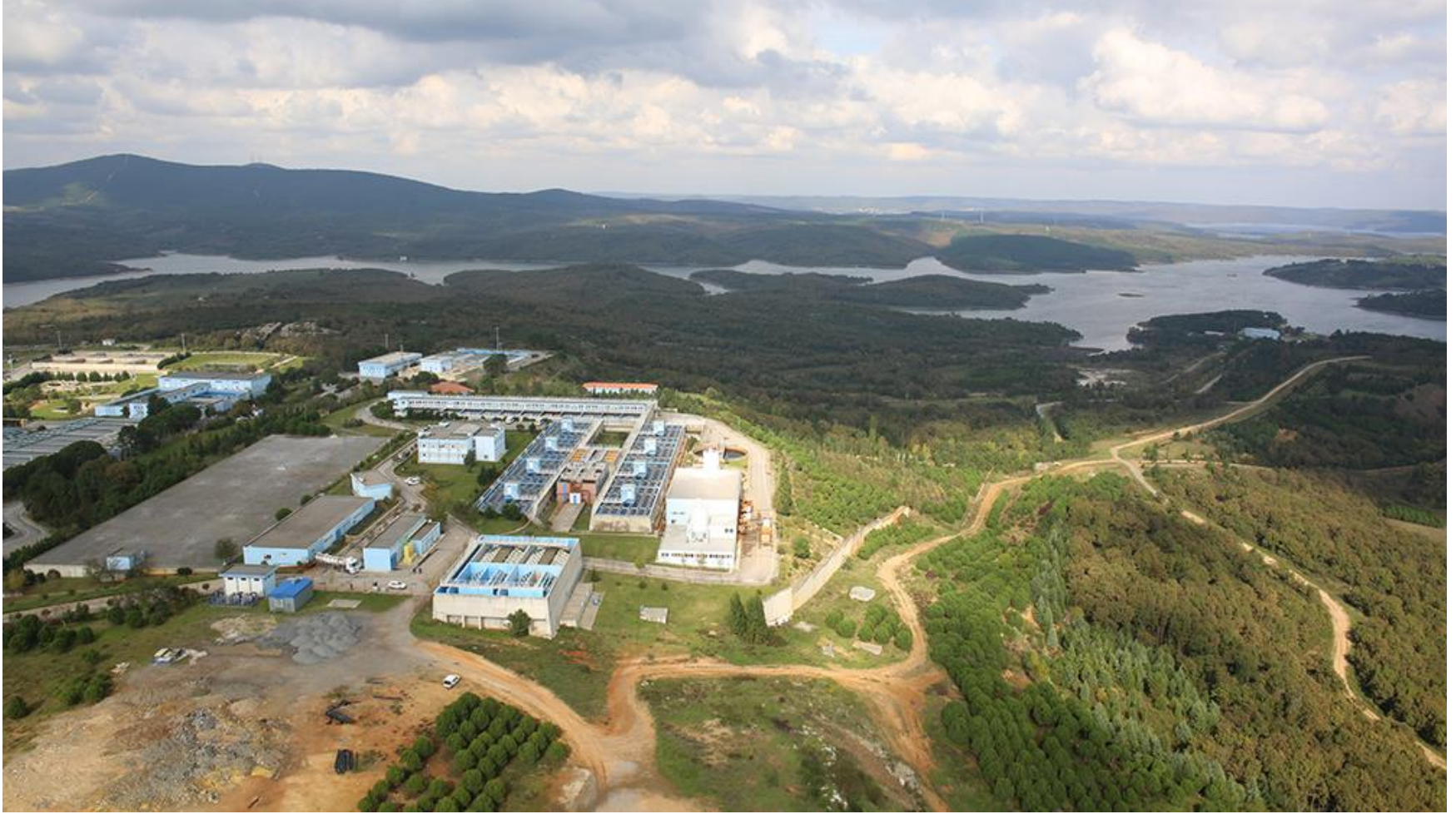
İSKİ Ömerli İçme Suyu Arıtma Tesisi
