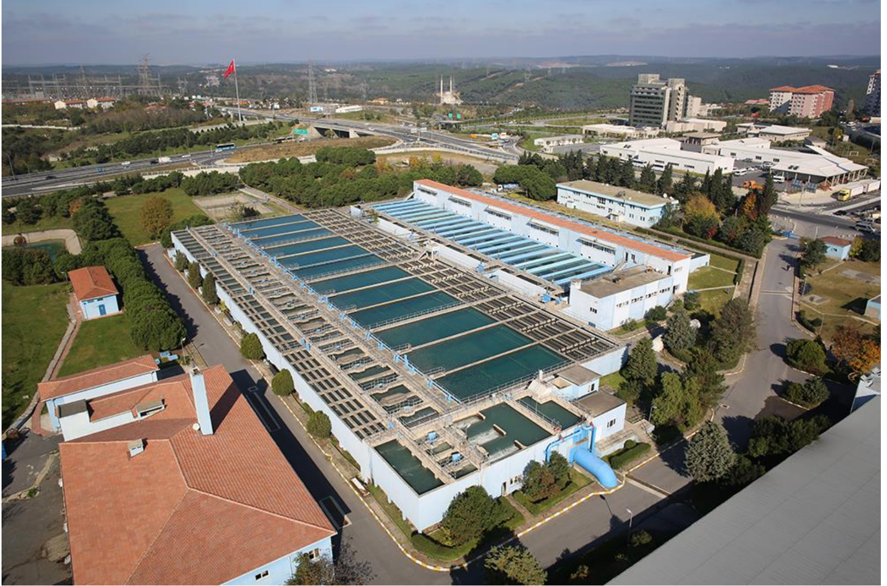
İSKİ Kağıthane İçme Suyu Arıtma Tesisi
