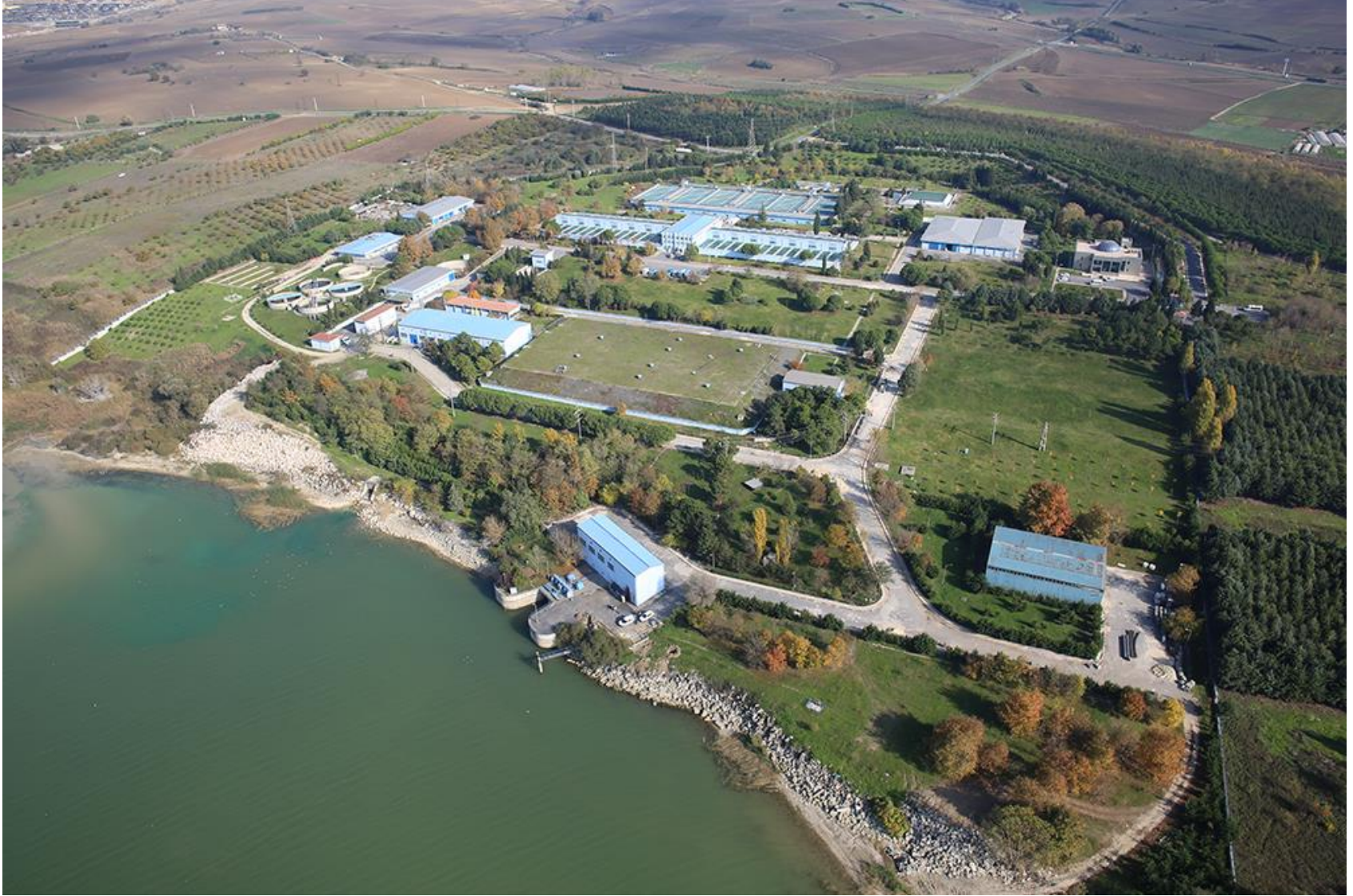
İSKİ Büyükçekmece İçme Suyu Arıtma Tesisi
