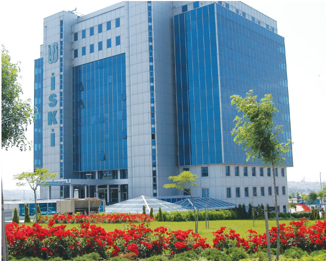
İSKİ Genel Müdürlüğü Merkez Binası
