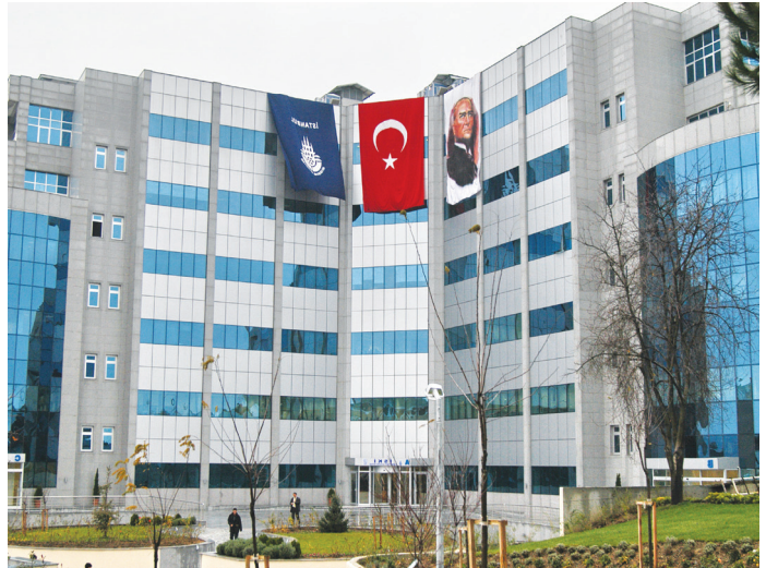
İSKİ Laboratuvar ve Ek Hizmet Binası
