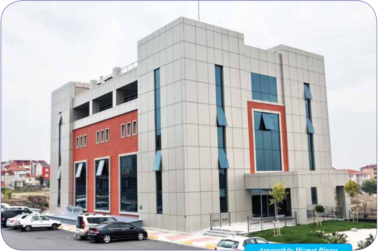
Arnavutköy Hizmet Binası
