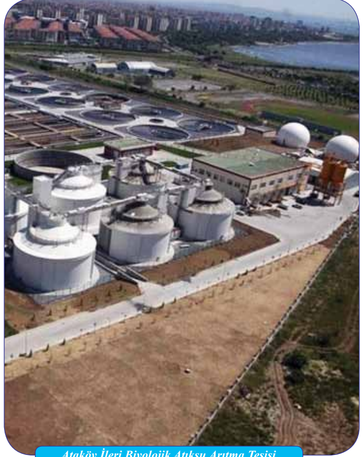
Ataköy İleri Biyolojik Atıksu Arıtma Tesisi
