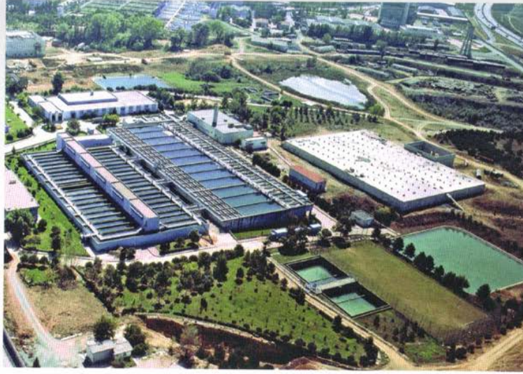
Kağıthane İçme Suyu Arıtma Tesisi
