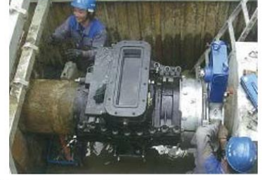
3) Döner sürücü cihaz montajı
