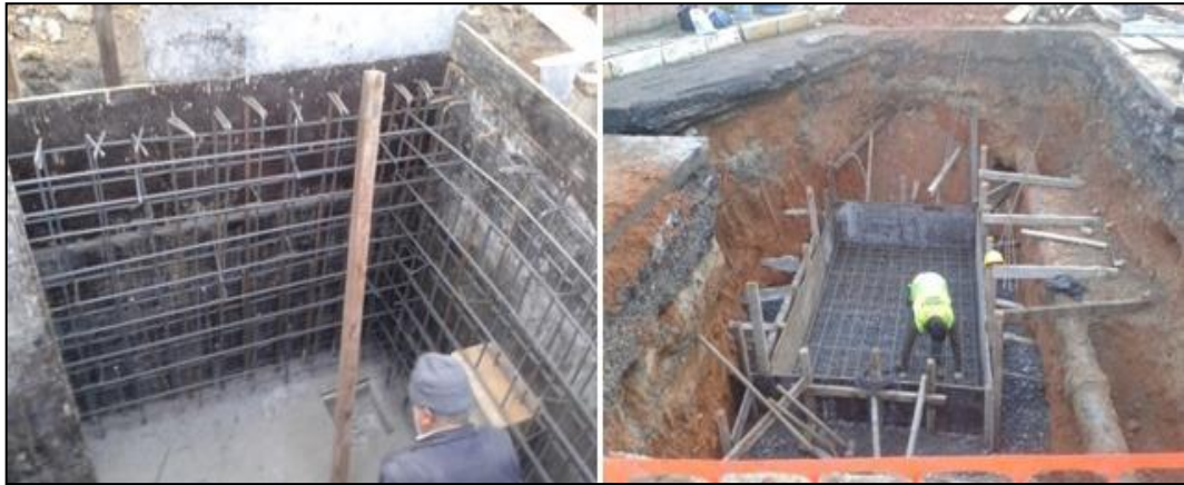
Şekil 11. DMA odası oluşturulması
