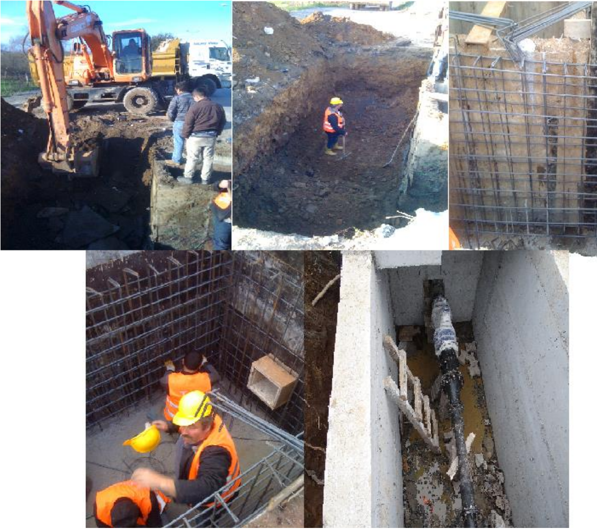
Şekil 122. DMA odası inşası-temel atma
