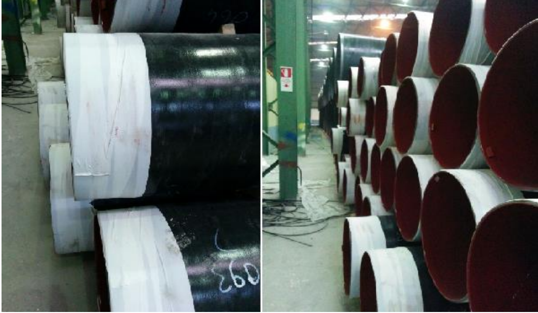
Şekil 27. Boru dış yüzeyinin kaplanması
