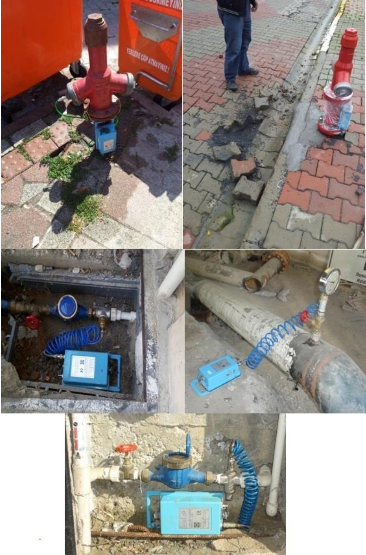
Şekil 134. Arazide basınç ölçümleri ve datalogger marifetiyle kaydedilmeleri
