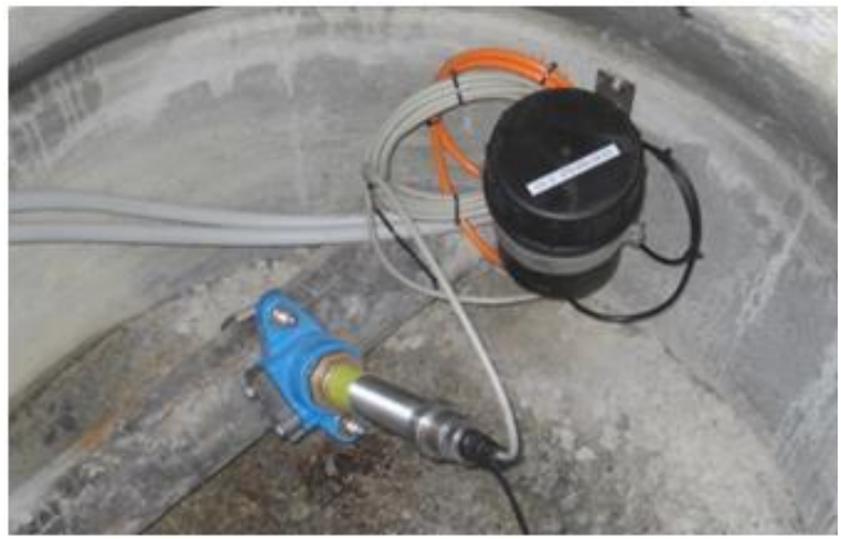
Şekil 64. Kelepçeli ultrasonik debimetreler - Clamp on Tip
