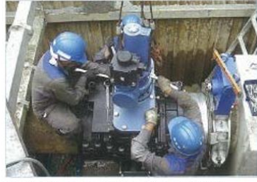
4) Delme makinesi montajı
