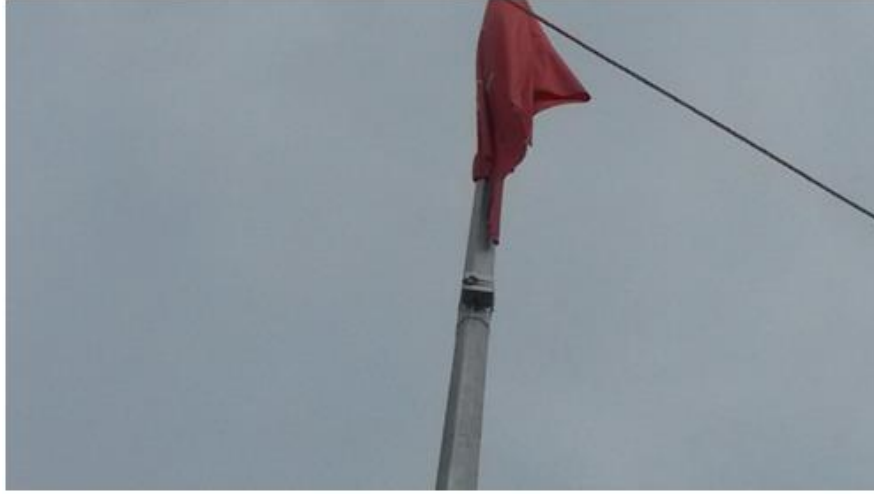
Şekil 105. Permalog sistem saha uygulaması-3 (bayrak direğine montajlanmış konstatör)
