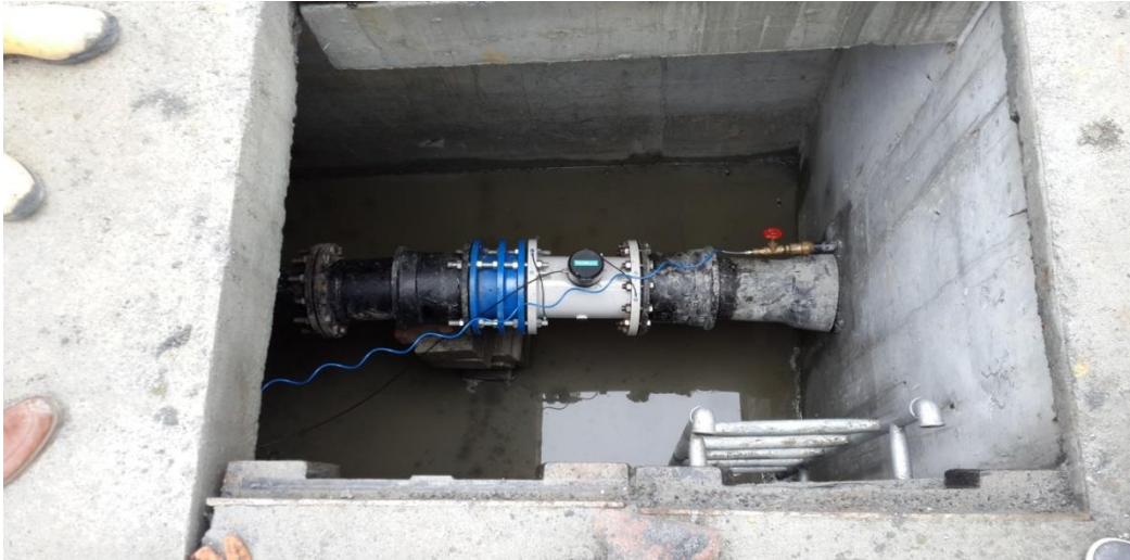
Şekil 62. DMA odasına monte edilmiş debimetre
