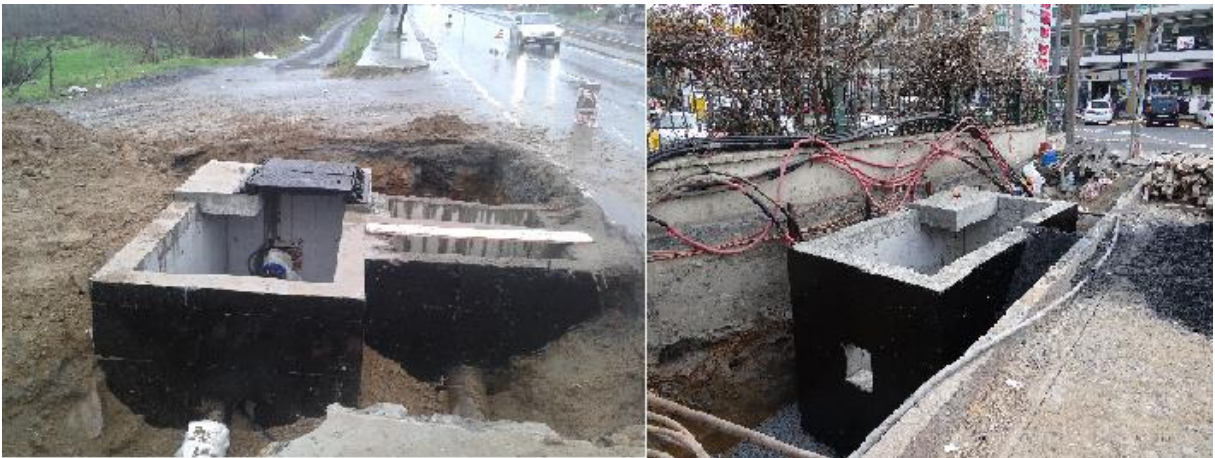
Şekil 123. DMA odası inşası-oda gövdesi beton dökülmüş hali
