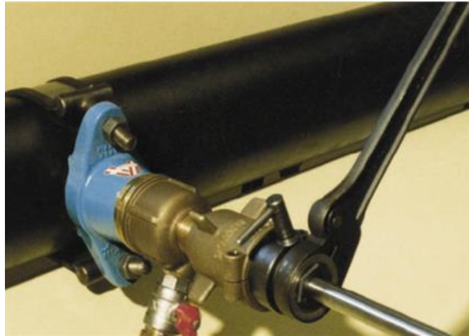
Şekil 117. Basınçlı hatta abone bağlantısı yapılması (AVK, 2016)
