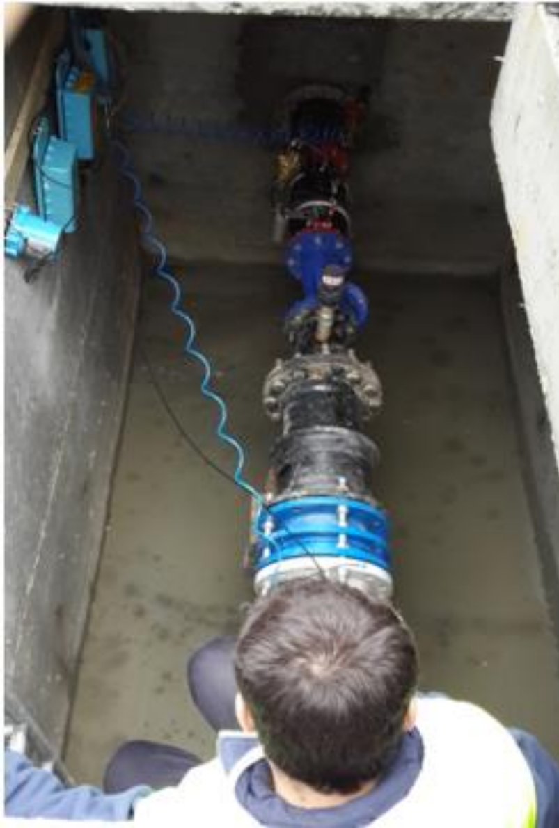
Şekil 12. Kemerburgaz Bölgesi'nde oluşturulmuş örnek DMA odası
