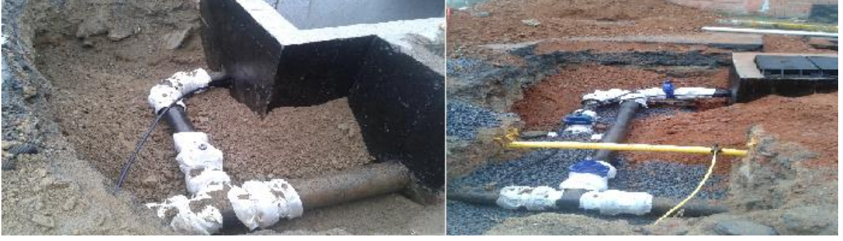
Şekil 124. DMA odası borulama ve ekipman montajı
