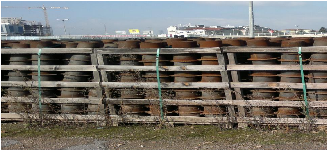
Şekil 20. Açık alanda hatalı depolama sonucu paslanmış malzemeler
