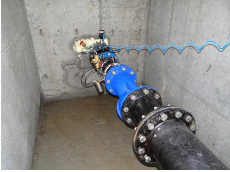
Şekil 88. Örnek vantuz montajı
