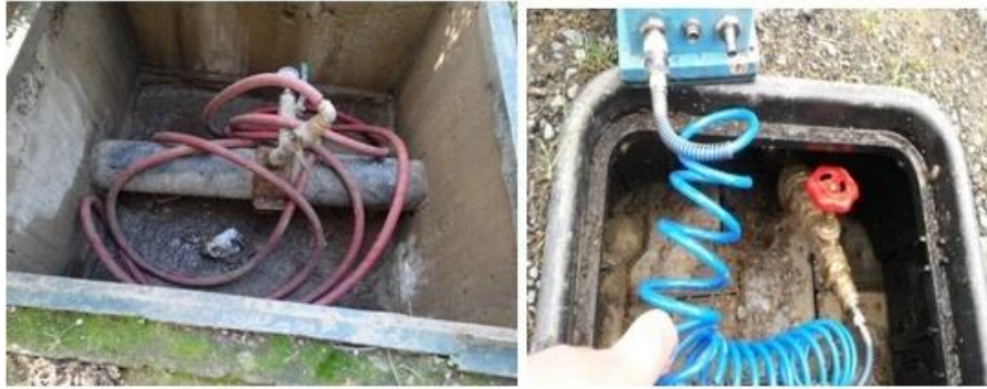
Şekil 133. Arazide basınç uygulaması örnekleri
