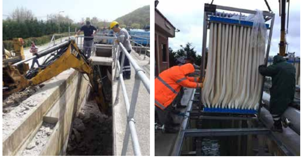
Şekil 5. Son çöktürme havuzunun MBR için uygun hale getirilmesi (solda) ve GenMBR modüllerinin havuza indirilmesi (sağda)
