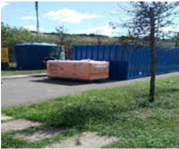
a) Şile UF Pilot Tesisi
