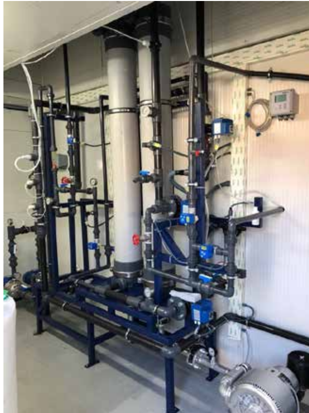
Şekil 4. Şile ve Paşaköy'de kullanılan GenUF modüllerinin görüntüleri (solda Şile İçmesuyu Arıtma Tesisi gerçek görünümü bulunmaktadır)
