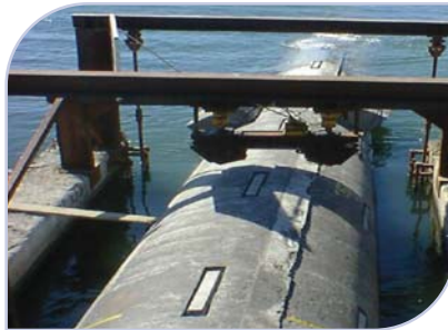
KADIKÖY DENİZ DEŞARJ BORUSU İÇ YÜZEYİNİN MG ANOT İLE GALVANİK USULLE KORUNMASI
