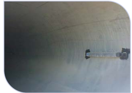
KADIKÖY DENİZ DEŞARJ BORUSU İÇ YÜZEYİNİN MG ANOT İLE GALVANİK USULLE KORUNMASI
