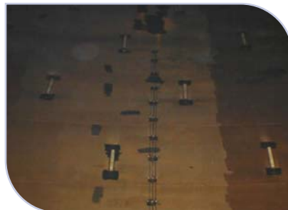
ATIKSU DENİZ DEŞARJ HATLARINA UYGULANAN KATODİK KORUMA
