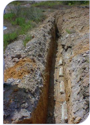
GALVANİK USULLE KATODİK KORUMASI YAPILAN İSALE HATTI Mg ANOTLARIN DÖŞENMESİ
