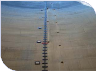
KADIKÖY DENİZ DEŞARJ BORUSU İÇ YÜZEYİNİN MG ANOT İLE GALVANİK USULLE KORUNMASI
