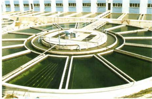
DEGRAMONT TİPİ ÇÖKELTİM HAVUZU
