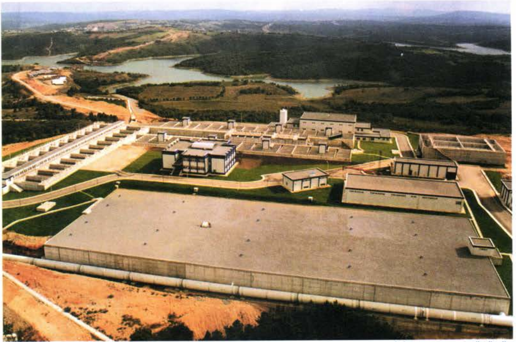
EMİRLİ YAVUZ SULTAN SELİM ARITMA TESİSİNDEN GENEL GÖRÜNÜŞ
