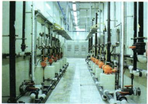
ALÜMİNYUM SÜLFAT ve POLİELEKTROLİT DOZAJ POMPALARI
