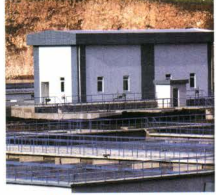
DURULTUCU (Çöktürme) HAVUZLARI
