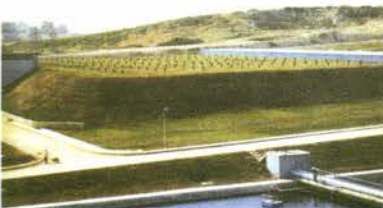
30.000m 3 KAPASİTELİ TEMİZ SU DEPOSU
